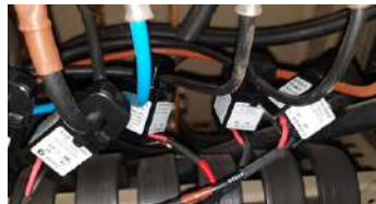
Transformateurs de courant
