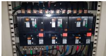
Transformateurs de courant
