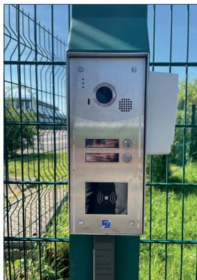
Interphone vidéo 2 boutons à l'entrée du centre de rayonnement synchrotron français, Ile de France
