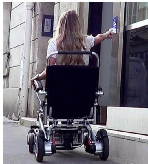
Selon le support, la plaque d'information fournie avec le bouton poussoir peut être très facilement fixée par adhésifs (inclus), collée ou vissée. Une seule exigence : la positionner entre 0,90 et 1,30 m de hauteur, et à plus de 0,40 m d'un coin du mur.
