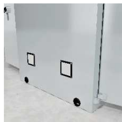
2 ventilateurs 230 VAC et 4 entrées équipées de grilles aluminium avec filtres de 120 x 120 mm.
