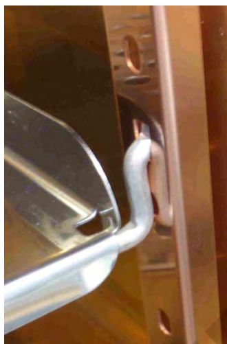
Figure 14-5. Installation d'une étagère métallique perforée
